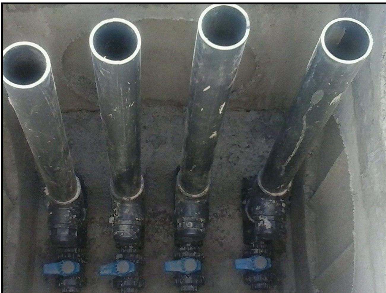
**Uscite a tenuta stagna multiple con valvole e tubi di carico (Guida Battenti)**
